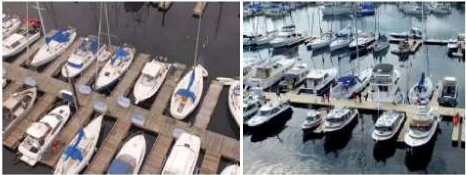
Gambar. Contoh Penerapan Titik Labuh/ Singgah Kapal Yacht yang mengkombinasikan Single Berth Configuration (kiri) dan Double Berth Configuration (kanan) (Lokasi: Nanaimo Yacht Club Dock, Kanada, Sumber: https://www.nanaimoyc.ca/images/ )
